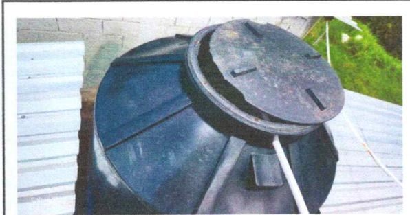
Foto 4: SUSTITUCIÓN DE DEPOSITO DE AGUA 2500 LT
