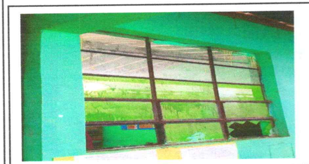
Foto 5: MEJORAMIENTO DE VENTANA CON BALCÓN
