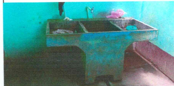
Foto 8: SUSTITUCIÓN DE PILA POR PILA DE CEMENTO DE DOS LAVADERAS
