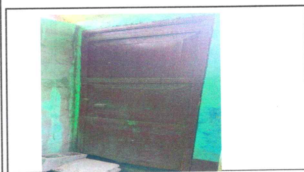
Foto 3: SUSTITUCIÓN DE PUERTA
