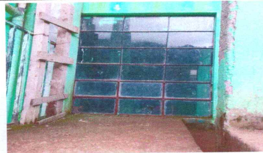
Foto 10: SUSTITUCIÓN DE ESTRUCTURA DE VENTANA
