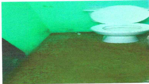
Foto 7: REPARACIÓN DE INODORO CON ACCESORIOS
