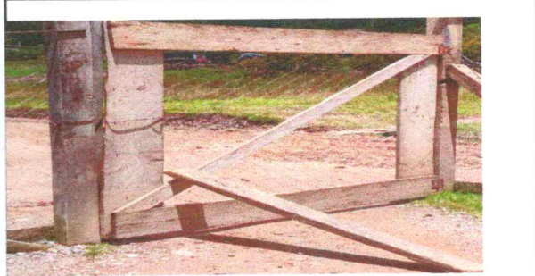
Foto 2: SUSTITUCIÓN DE PORTÓN 2.5 MTS
