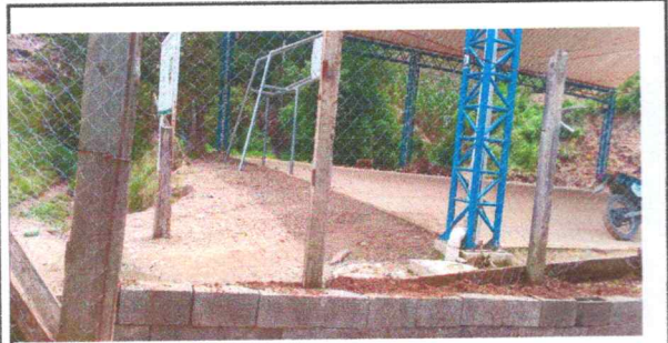
Foto 1: REPARACIÓN DE MURO PERIMETRAL Y DE CONTENCIÓN
