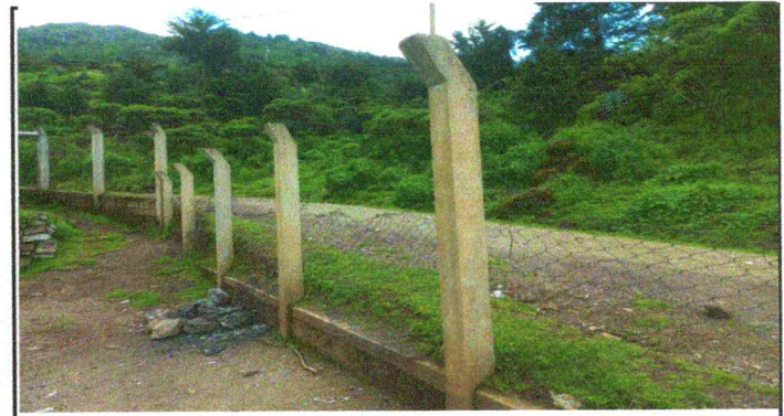
FOTO 4: REPARACION DE MURO PERIMETRAL
