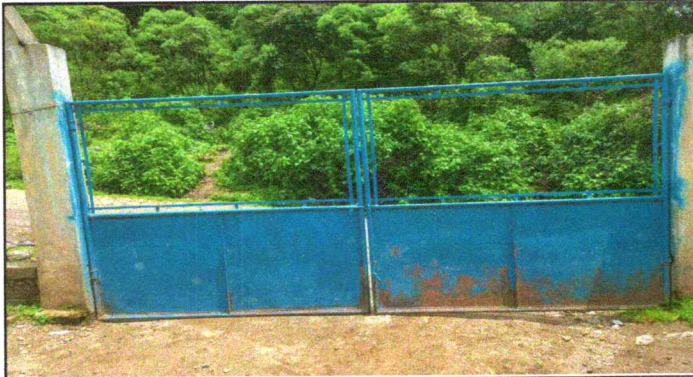
FOTO 1: SUSTITUCIÓN DE PORTON DE METAL
