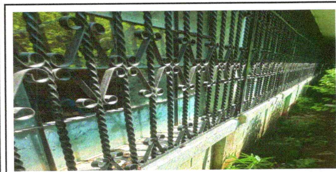
FOTO 5: BALCONES DE METAL
