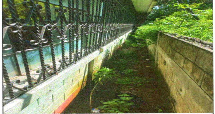
FOTO 2: PINTURA EN MUROS PERIMETRALES
