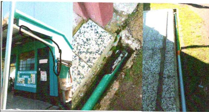
Foto 5: SUSTITUCION DE TUBERIA PVC LINEA PRINCIPAL DE AGUAS PLUVIALES
