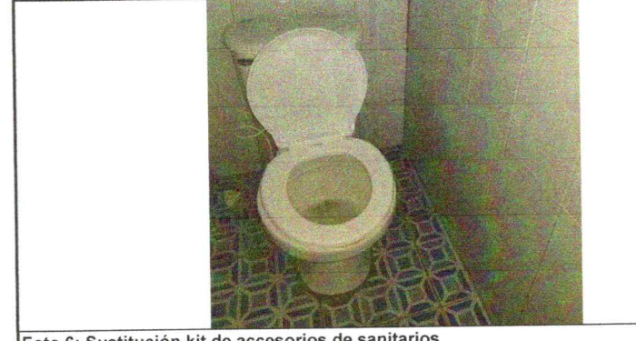
Foto 6: Sustitución kit de accesorios de sanitarios
