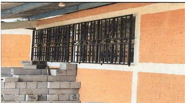
Foto 3: instalación de balcones de aula
