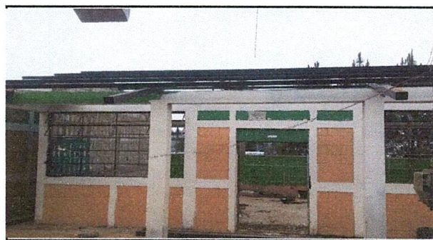
Foto 6: sustitución de techo, ventanas, puerta, costaneras canales y balcones de aula
