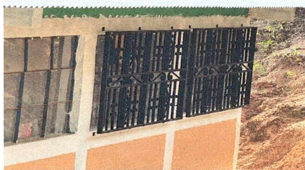
Foto 2: instalación de balcones de aula
