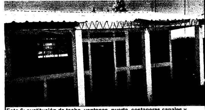
Foto 6: sustitución de techo, ventanas, puerta, costaneras canales y balcones de aula
