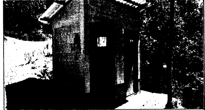
Foto 4: sustitución de puertas de servicios sanitarios
