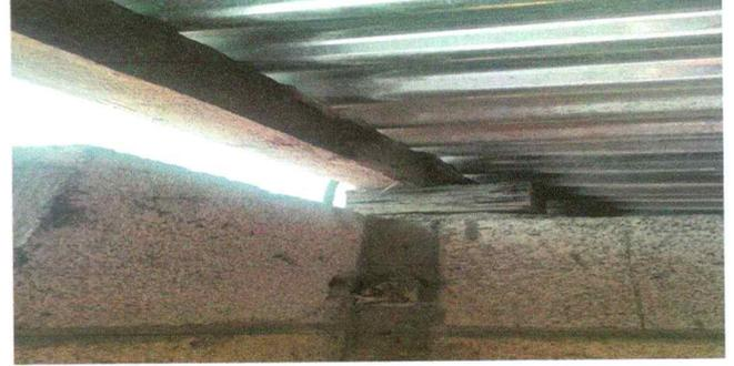
FOTO 2 : SUSTITUCION DE ESTRUCTURA DE MADERA POR METAL
