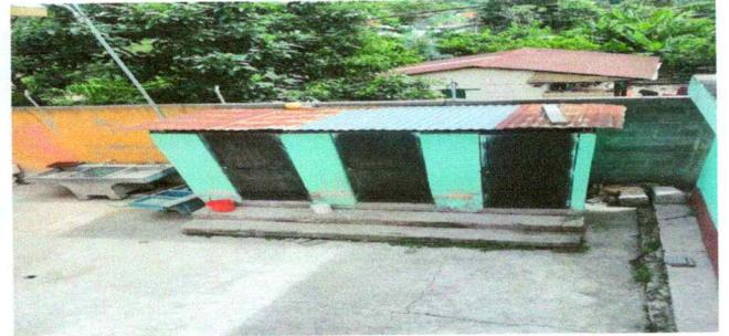
FOTO 4: SUSTITUCION DE TECHO DE LAMINA Y MANTENIMIENTO A PUERTAS
