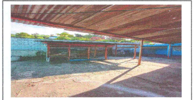
Foto 4: sustitución de estructura de soporte de madera por metal
