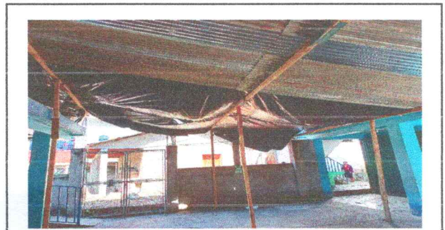
Foto 6: sustitución de lámina
