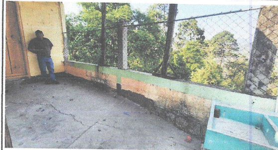
Foto 8: Vista del muro de contención, tiene un altura de 4 metros aproximadamente.
