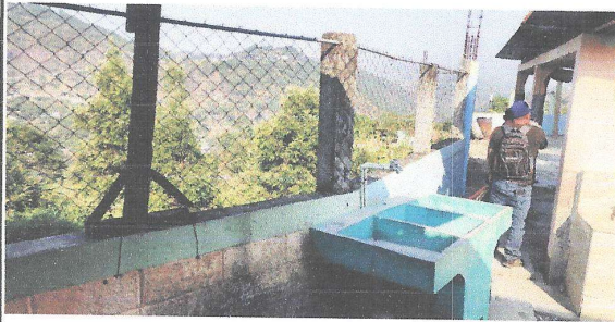
Foto 7: Vista del muro de contención.
