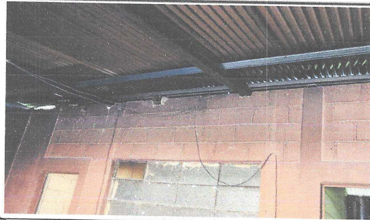
Foto 5: Vista interior de cubierta y techo existente en cocina.
