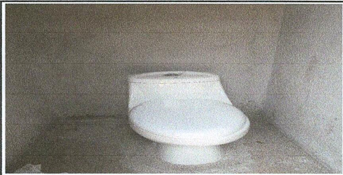
FOTO 3 COLOCACION DE LAS TASAS
