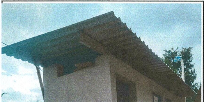
FOTO 4 TECHADO DE LOS BAÑOS
