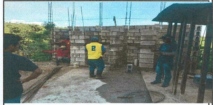
FOTO 4 CONSTRUCCION DE SANITARIOS
