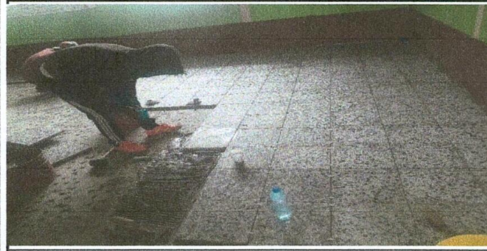
FOTO 1 SUSTITUCION DE PISO DE GRANITO
