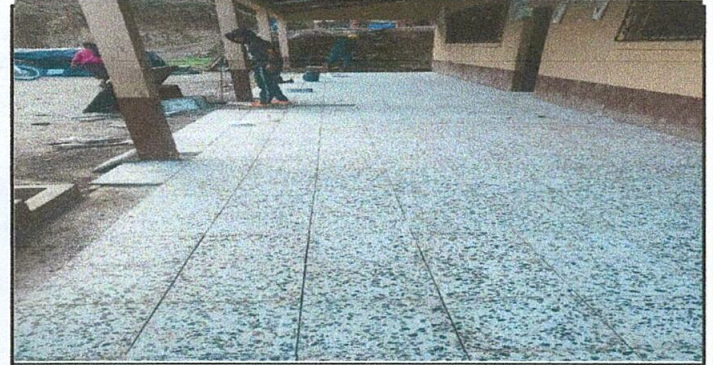
FOTO 2 COLOCACION DE PISO DE GRANITO
