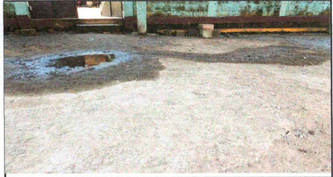
Foto 4: Sustitución de piso a torta Cemento
