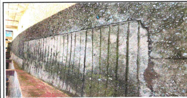
Foto 5: Reparación de piso de torta de concreto
