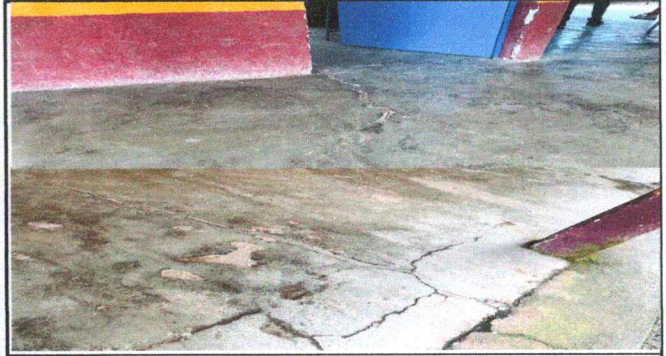
Foto 2: Reparación de piso cerámico
