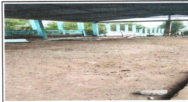
Foto 3: Sustitución de piso a torta de Cemente
