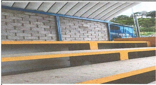
Foto 1: Reparación de muro perimetral de block
