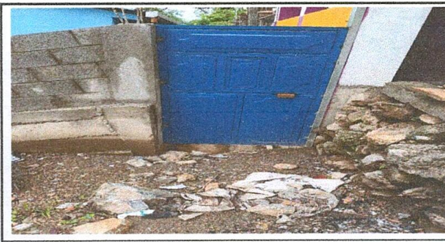
Foto 5: Sustitución de puerta de metal
