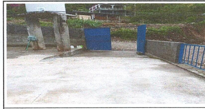
Foto 6: Sustitución de portón de metal
