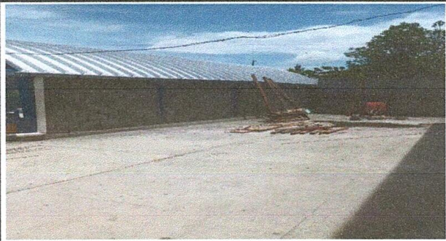
Foto 1: Reparación de muro perimetral de block
