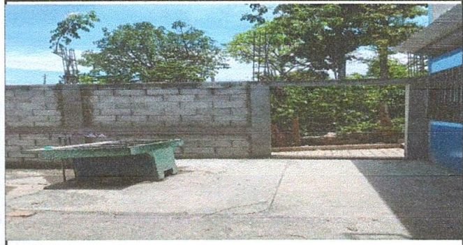
Foto 2: Sustitución de portón de metal
