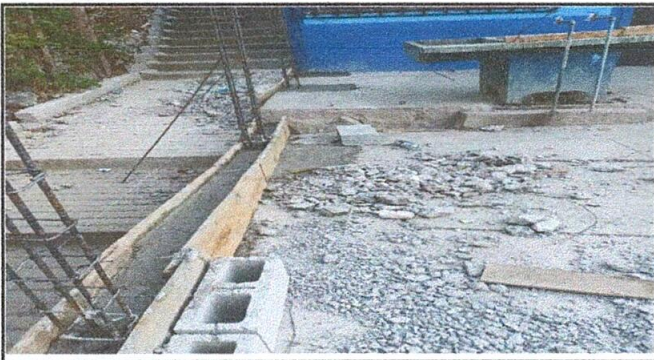
Foto 3: Reparación de muro perimetral de block
