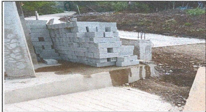
Foto 4: Reparación de muro perimetral de block con soleras intermedias
