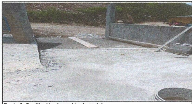
Foto 6: Sustitución de portón de metal
