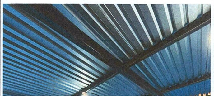
Foto 6: Sustitución de estructura de soporte de madera por metal
