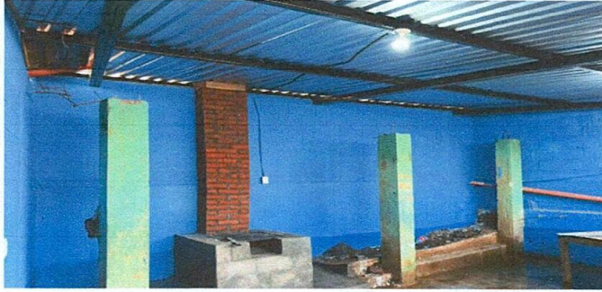
Foto 1: Sustitución de lámina por lámina troquelada calibre 26
