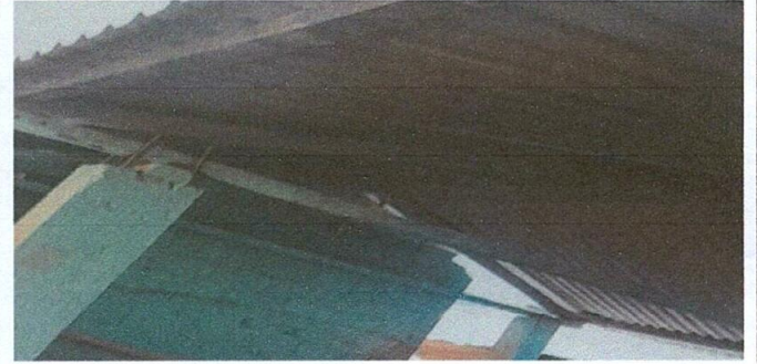
Foto 2: Sustitución de estructura de madera por metal
