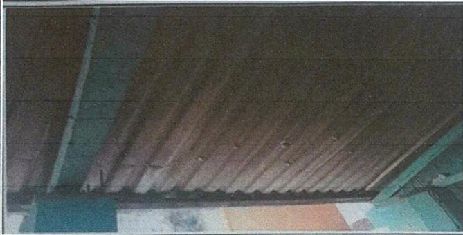
Foto 1: Sustitución de lámina por lámina troquelada calibre 26
