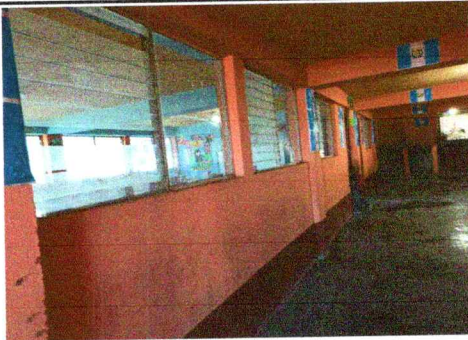
Foto 1: Sustitución de ventanas
