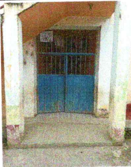
Foto 5: Sustitución de portón Primer Nivel
