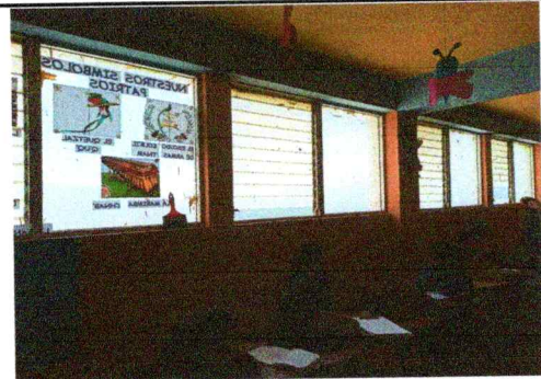
Foto 4: Sustitución de ventanas parte poniente segundo nivel
