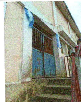
Foto 6: sustitución de portón Segundo Nivel
