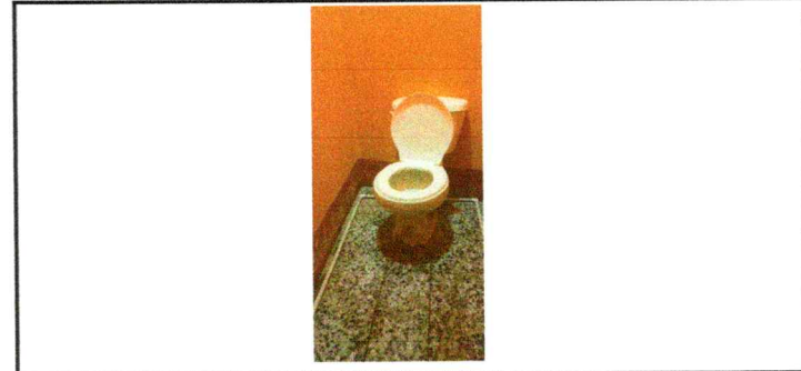
Foto 6: sustitución de inodoro
