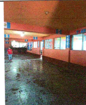
Foto 2: Ventanas a sustituir en segundo nivel interior
