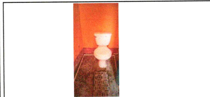
Foto 5: Sustitución de inodoro
