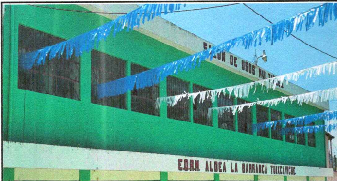
Foto 3: Las ventanas de aulas del segundo nivel representa peligro para los alumnos que reciben clases ahí, porque cuando juegan pelota, la misma llega a los vidrios y se rompen por lo tanto se necesitan balcones
