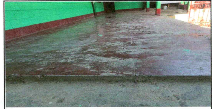
Foto 6: En dos aulas, dirección y en el corredor de la planta alta se necesita colocar piso porque esta deteriorada la que esta.
