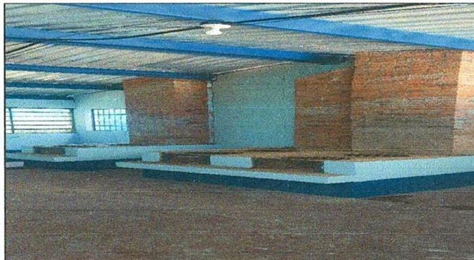
Foto 1: Sustitución de chimenea de concreto por ladrillos
