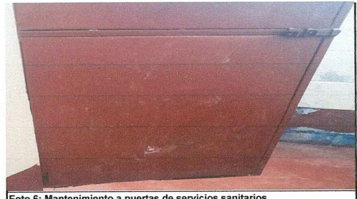
Foto 6: Mantenimiento a puertas de servicios sanitarios
