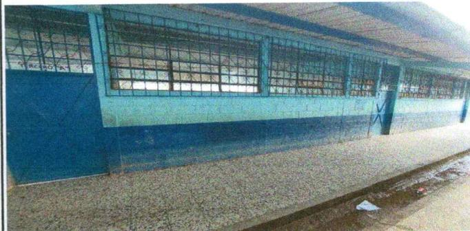
Foto2: Sustitución de puertas de metal
