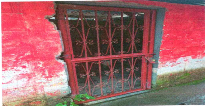
FOTO 1: REMOZAMIENTO DE PINTURA EN PUERTA TIPO BARANDA
