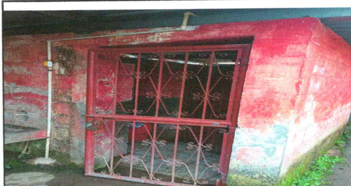
FOTO 2: REMOZAMIENTO DE PINTURA EN PUERTA TIPO BARANDA
