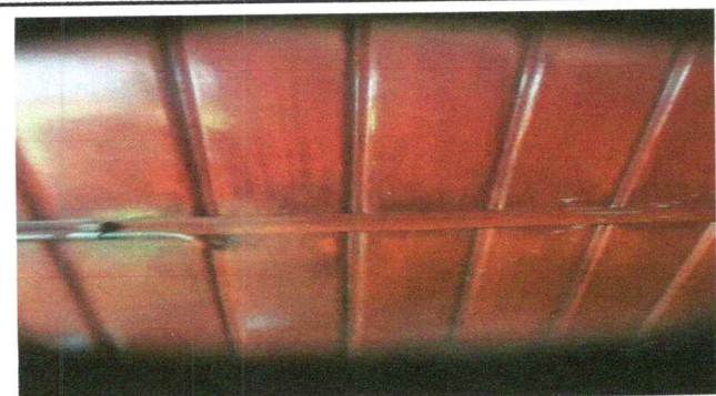
FOTO 3: REMOZAMIENTO EN PINTURA DE PUERTAS DE BAÑOS
