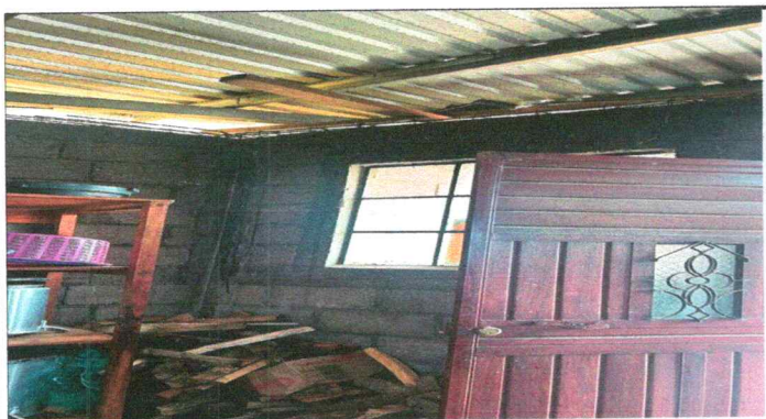
Foto 3: SUSTITUCIÓN DE PUERTAS DE METAL DE COCINA DE MODULO DE PRIMARIA DE ALDEA EL GRANADILLO
