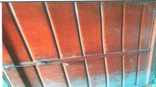
FOTO 4: REMOZAMIENTO EN PINTURA DE PUERTAS DE BAÑOS
