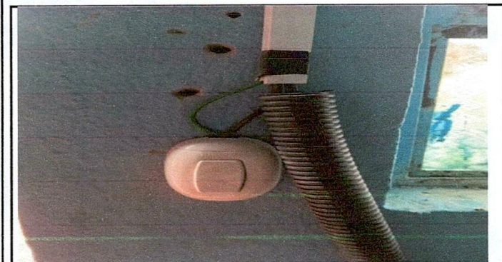
Foto 5: Reparación del cableado eléctrico.
