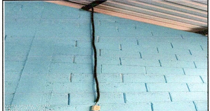
Foto 4: Sustrucción de interruptores simples por dobles.
