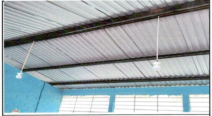
Foto 2: Mantenimiento de estructura de soporte de metal.
