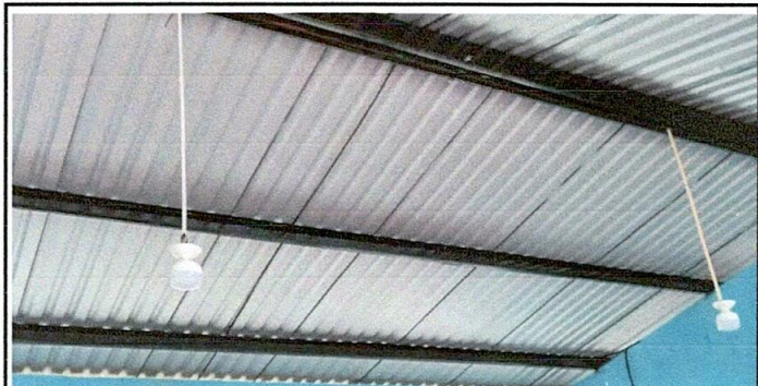
Foto 6: Sustitución de focos por ahorradores.
