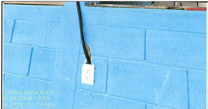
Foto 4: Sustitución de interruptores simples por dobles.
