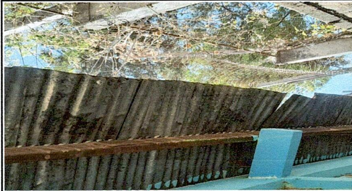
Foto 1: Cambio de lámina por lámina troquelada y mantenimiento a estructura portante de metal
