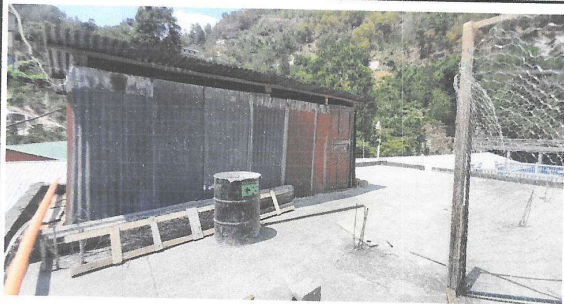
Foto 11: Área del modulo 1, donde se hará levantado de muro y se colocará techo metálico.
