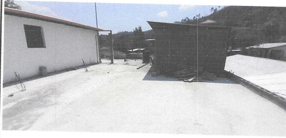
Foto 7: Área del modulo 1, donde se hará levantado de muro.
