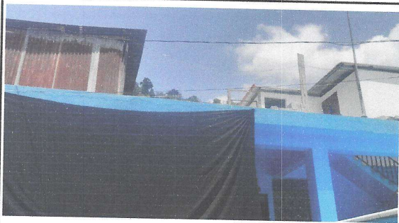
Foto 9: Vista del modulo 1, se observa aula.
