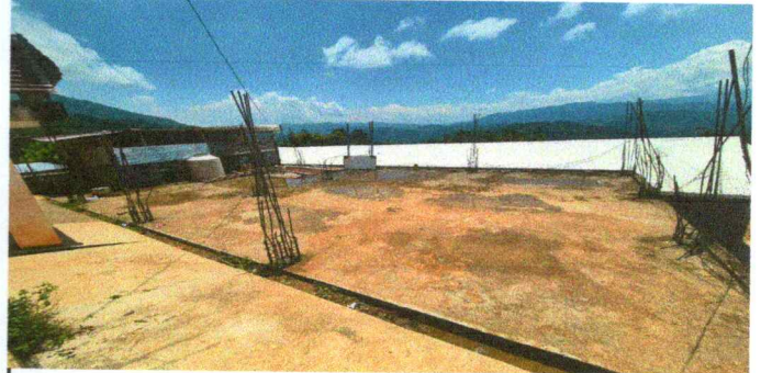
Foto 4: Instalación de barandas de metal
