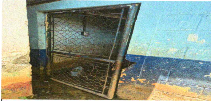
Foto 5: Sustitución de puerta principal para baños
