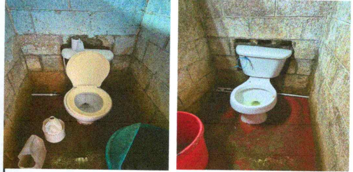
Foto 2: Sustitución de tasas para baños lavables
