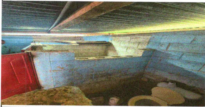
Foto 3: Instalación de Azulejo para baños
