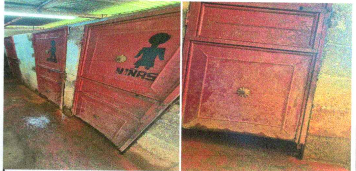
Foto 4: Sustitución de puertas en servicios sanitarios
