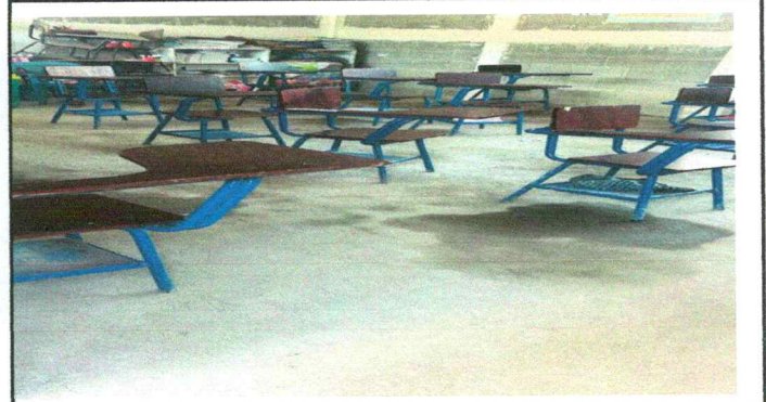
Foto 2: SUSTITUCIÓN DE PISO DE TORTA POR PISO DE GRANITO EN MODULO DE PRE-PRIMARIA DE ALDEA EL GRANADILLO
