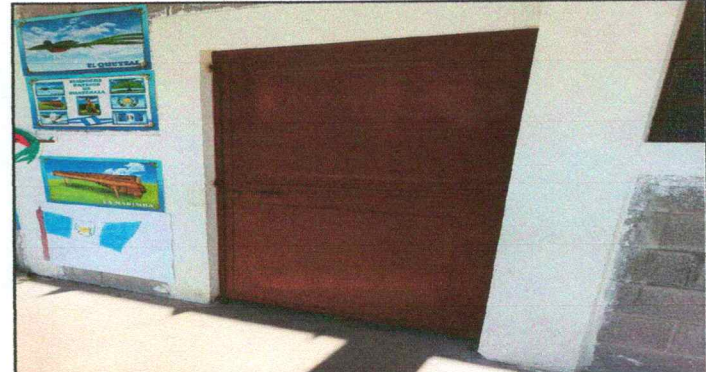
Foto 4: SUSTITUCIÓN DE PUERTA DE METAL EN MODULOS DE PRE-PRIMARIA DE ALDEA EL GRANADILLO
