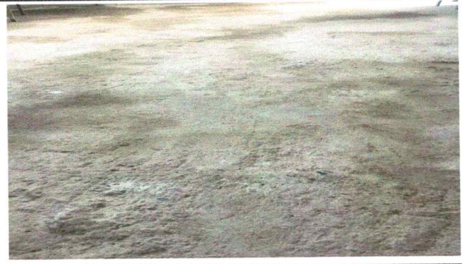
Foto 2: SUSTITUCIÓN DE PISO DE TORTA POR PISO DE GRANITO EN MODULO DE PRE-PRIMARIA DE ALDEA EL GRANADILLO
