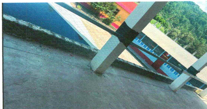
Foto 3: SUSTITUCIÓN DE BARANDA EN MODULO DE PRE-PRIMARIA DE ALDEA EL GRANADILLO
