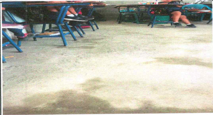
Foto 1: COLOCACION DE PISO GRANITO EN AULAS DE SEGUNDO NIVEL
