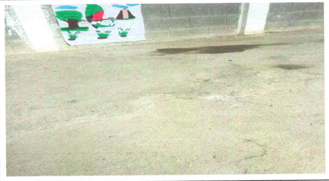
Foto 4: SUSTITUCIÓN DE PISO DE TORTA POR PISO DE GRANITO EN MODULO DE PRE-PRIMARIA DE ALDEA EL GRANADILLO
