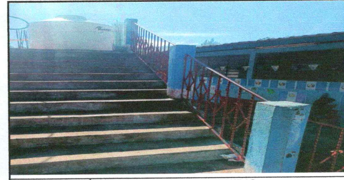
Foto 6: FUNDICIÓN DE COLUMNAS PARA BARANDAS
