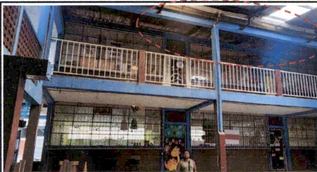
Foto 5: Vista del modulo 2, se observa el canal, el cual al llover no se da abasto para desfogar el agua pluvial.
