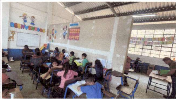
Foto 7: muro de madera de división de aulas el cual se hará de block.
