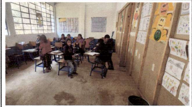
Foto 8: muro de madera de división de aulas el cual se hará de block.
