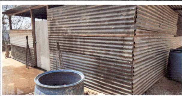
Foto 9: Vista del área de cocina la cual se reforzará.
