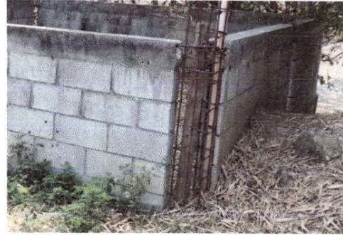
Foto 8: Se fundirán la columnas.
