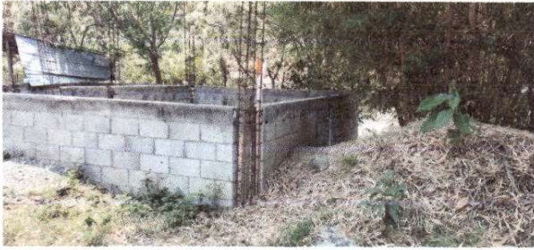
Foto 7: Se levantan muro de block.
