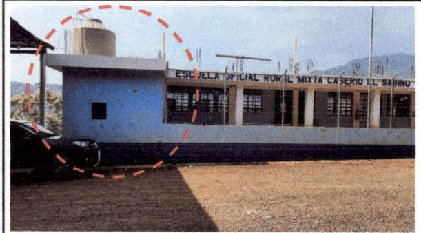
Foto 2: Fachada de la escuela, ubicación de cocina y baños.
