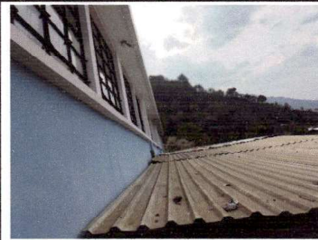
Foto 9: Vista de las ventanas en la parte de atrás del modulo 1.
