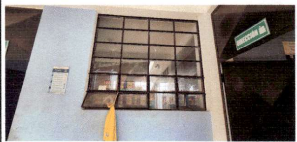
Foto 8: Vista de las ventanas.
