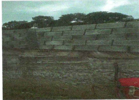
Foto 8: REPELLO EN MURO DE CONTENCIÓN
