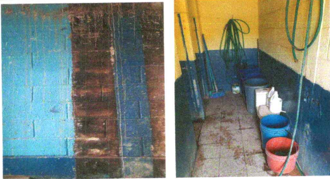
Foto 9: REPELLO Y PINTURA EN BAÑOS Y COCINA
