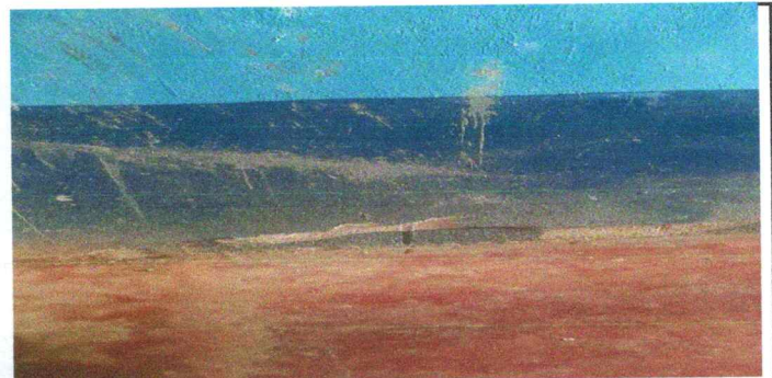
Foto 6: PINTURA EN MAL ESTADO
