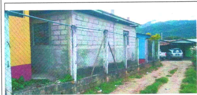
FOTO 11: REPARACIÓN DE MURO PERIMETRAL EN MALAS CONDICIONES
