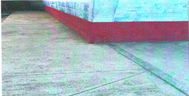
Foto 2: MEJORAMIENTO DE PINTURA DE MODULO DE INEB DE ALDEA EL GRANADILLO
