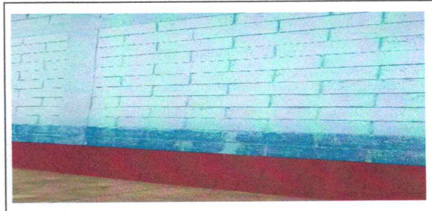
FOTO 12: PINTURA EN MUROS EXTERIORES
