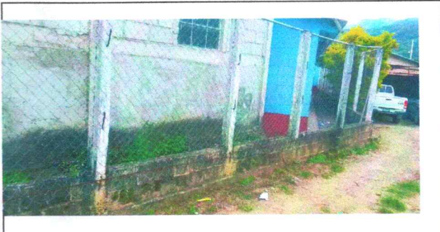
FOTO 10: REPARACIÓN DE MURO PERIMETRAL
