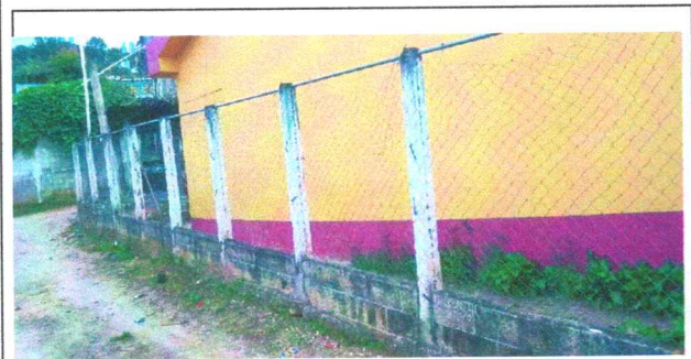
FOTO 9 : REPARACIÓN DE MURO PERIMETRAL
