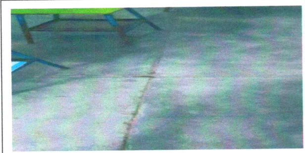
Foto1: SUSTITUCIÓN DE PISO DE TORTA DE COCNETRO POR GRANITO EN MODULO DE INEB DE ALDEA EL GRANADILLO
