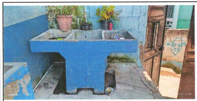
Foto 5: Sustitución de pila de 2 lavaderos
