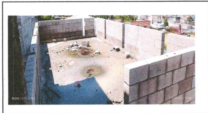
Foto 3: Mejoramiento de piso
