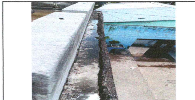
Foto 6: Canales y bajadas de agua pluvial
