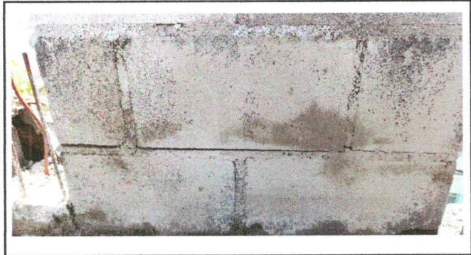
Foto1: Reparación de muros perimetrales.
