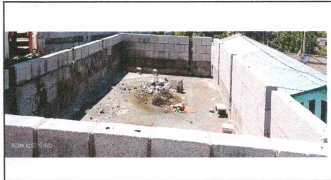
Foto 4: Mejoramiento de cocina
