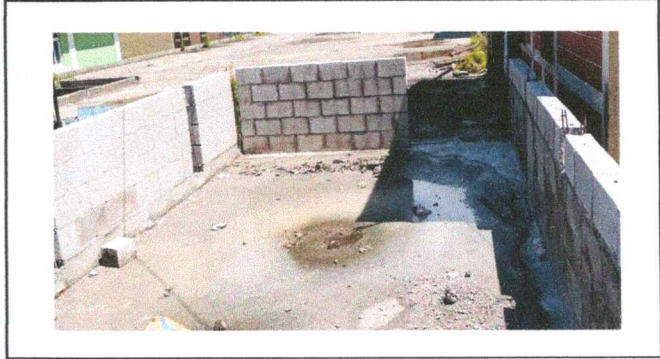
Foto 2: Mejoramiento de puerta
