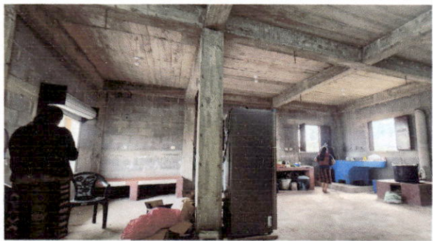
Foto 9: Se remozara aplicando Repello y alisado, además se instalara azulejo en muebles y paredes, se hará aun pila de concreto.
