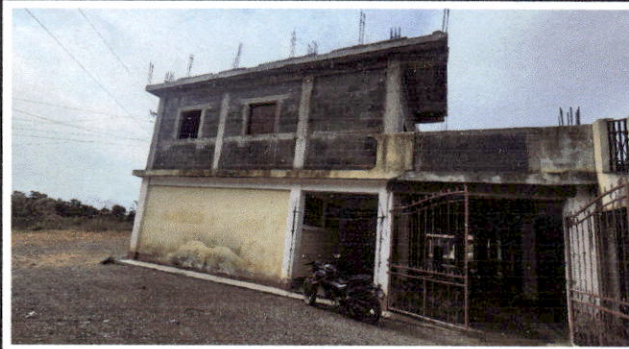
Foto 3: Vista de cocina se observa el block Visto.
