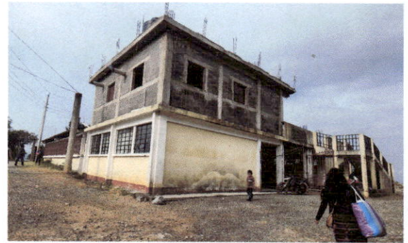
Foto 4: Vista de cocina se observa el block Visto.
