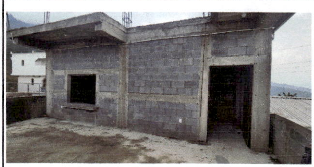
Foto 2: Vista de fachada de la cocina, se colocara repello y alisado.
