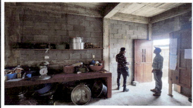
Foto 8: Vista del mueble de concreto, donde se le colocara azulejo.
