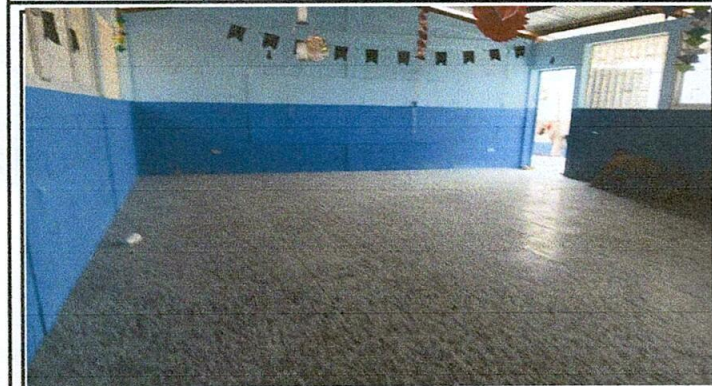
Foto1: terminacion de colocacion de piso granito
