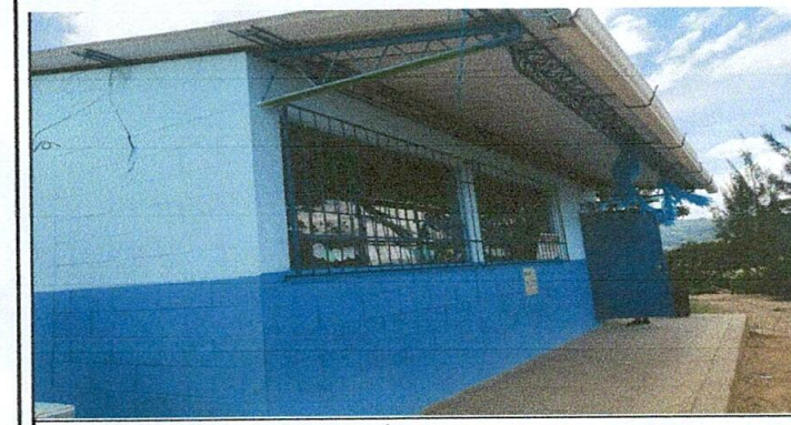
Foto 5: terminacion de puertas y chapas
