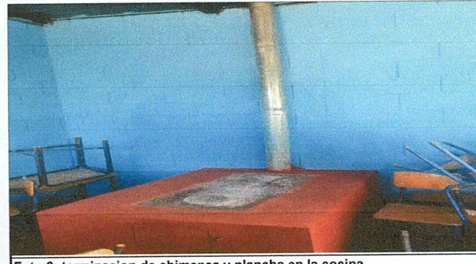
Foto 6: terminacion de chimenea y plancha en la cocina
