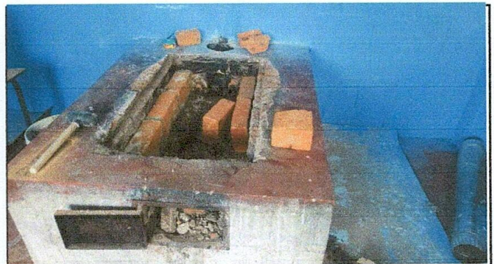
Foto 4: colocacin de nueva plancha y chimena
