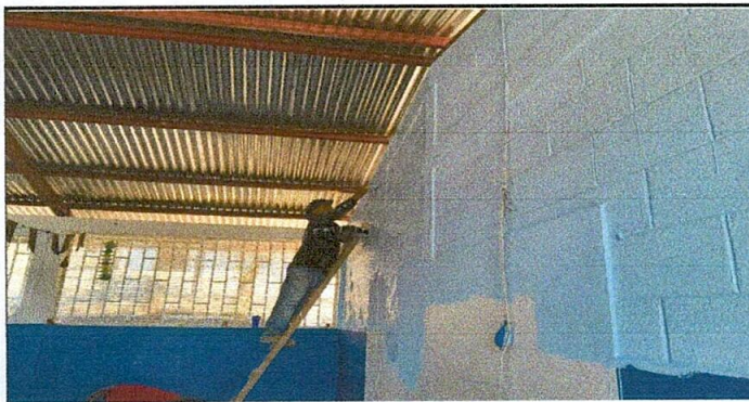
Foto 3: pintada de aulas afuera y adentro
