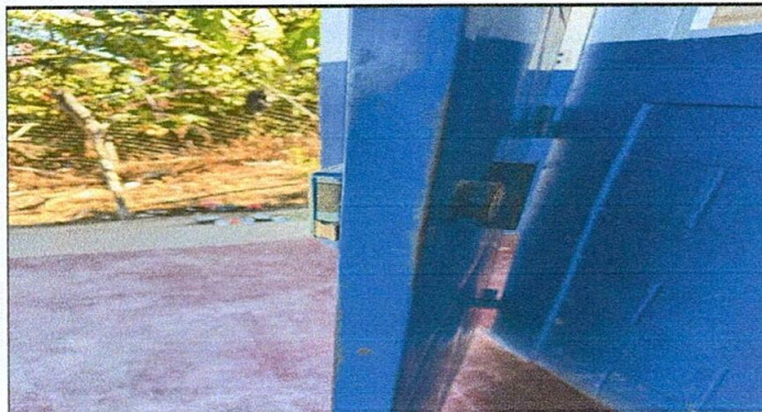
Foto 5: sustitucion de chapa
