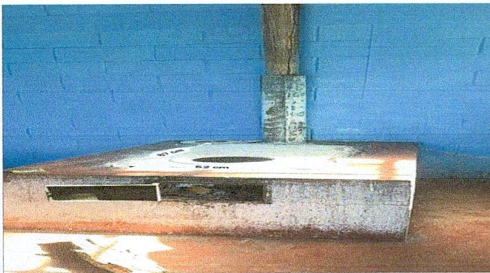
Foto 3: sustitucion de plancha y chimenea de cocina escolar
