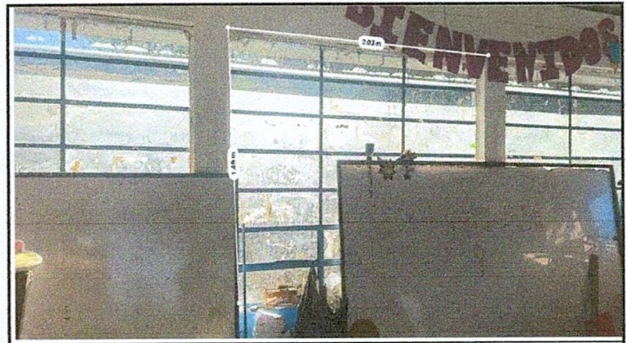
Foto 4: sustitucion de balcones
