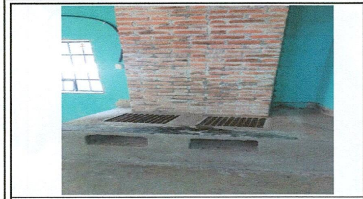
Foto1: SUSTITUCION DE ESTUFAS
