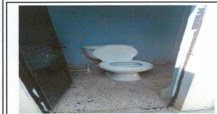
Foto 3: SUSTITUCION DE INODORO
