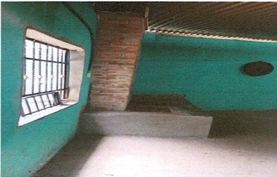
Foto 5: SUSTITUCION DE ESTUFA
