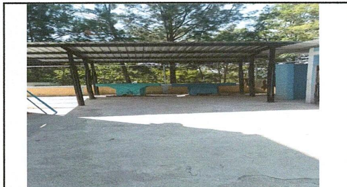
Foto 4: SUSTITUCION DE LAMINA Y ESTRUCTURA PORTANTE
