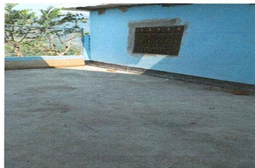
Foto 4: SUSTITUCION DE VENTANAS
