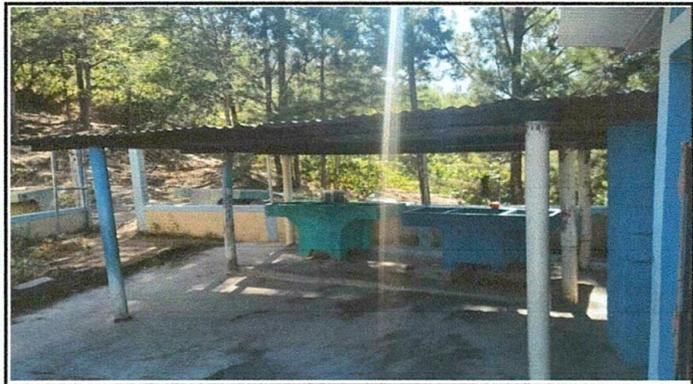
Foto 4: Cambio de lamina por lámina troquelada calibre 26 y estructura portante de madera por metal
