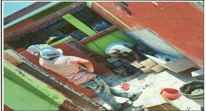
Foto 2: Sustitución de Mingitorios
