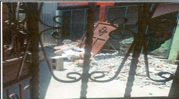
Foto 3: Mantenimiento de puertas de servicios sanitarios
