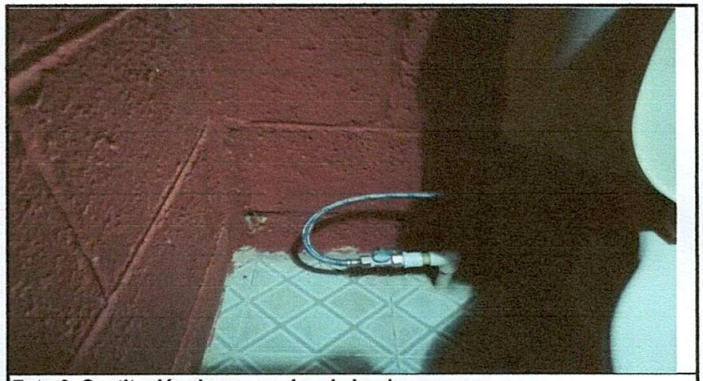
Foto 6: Sustitución de accesorios de inodoros
