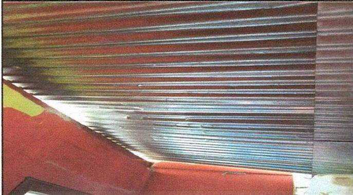
Foto 1: Sustitución de lámina por lámina troquelada calibre 26
