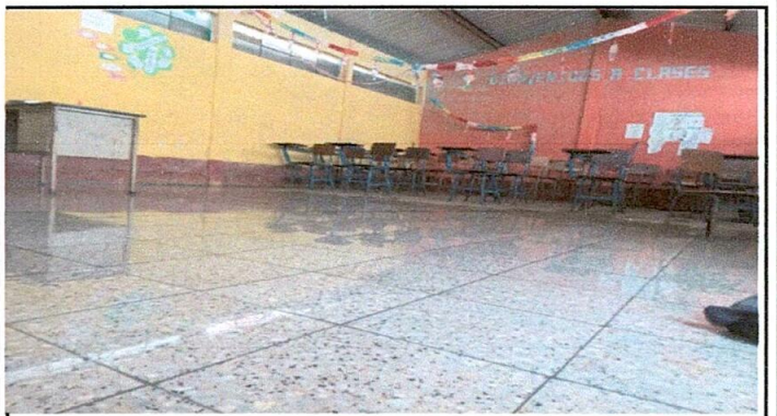
Foto 4: aula con su piso de granito
