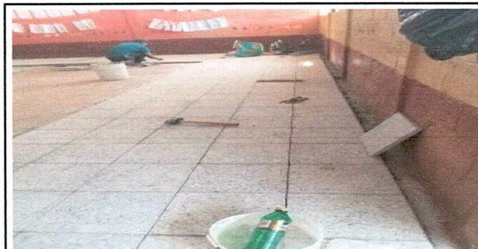
Foto 5: colocación de piso de granito en aula No. 2.
