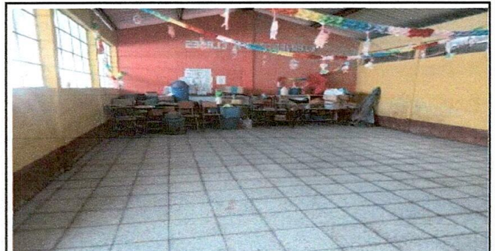
Foto 6: colocación piso de granito en aula No. 3.
