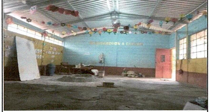
Foto 2: reparación del piso de concreto en una de las aulas
