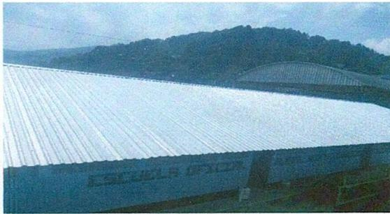
Foto 1: SUSTITUCIÓN DE LÁMINA POR LÁMINA
